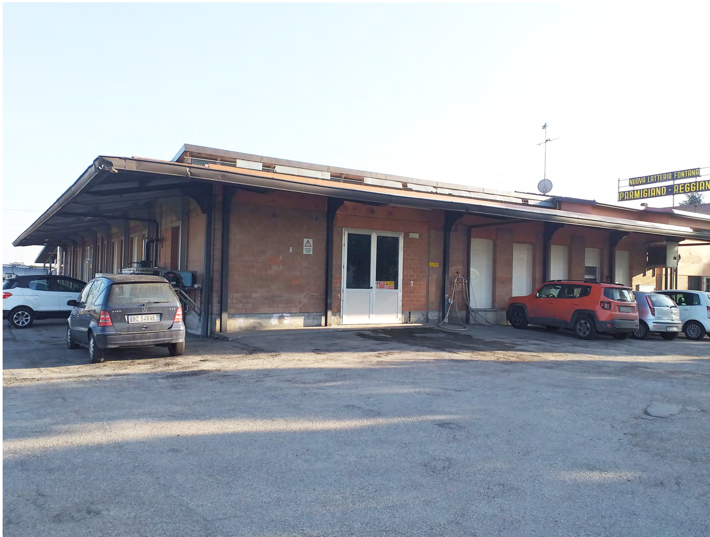
Foto 16 Fronte Nord – Ovest
