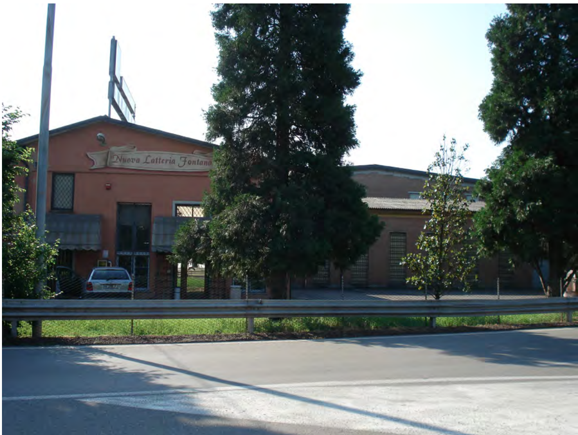
Foto 4. Il fronte Ovest
