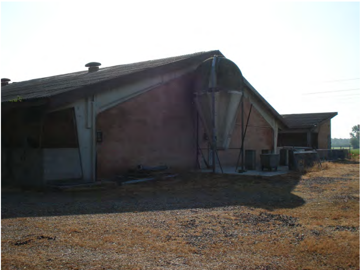
Foto 12. Le porcilaie, fronte Sud
