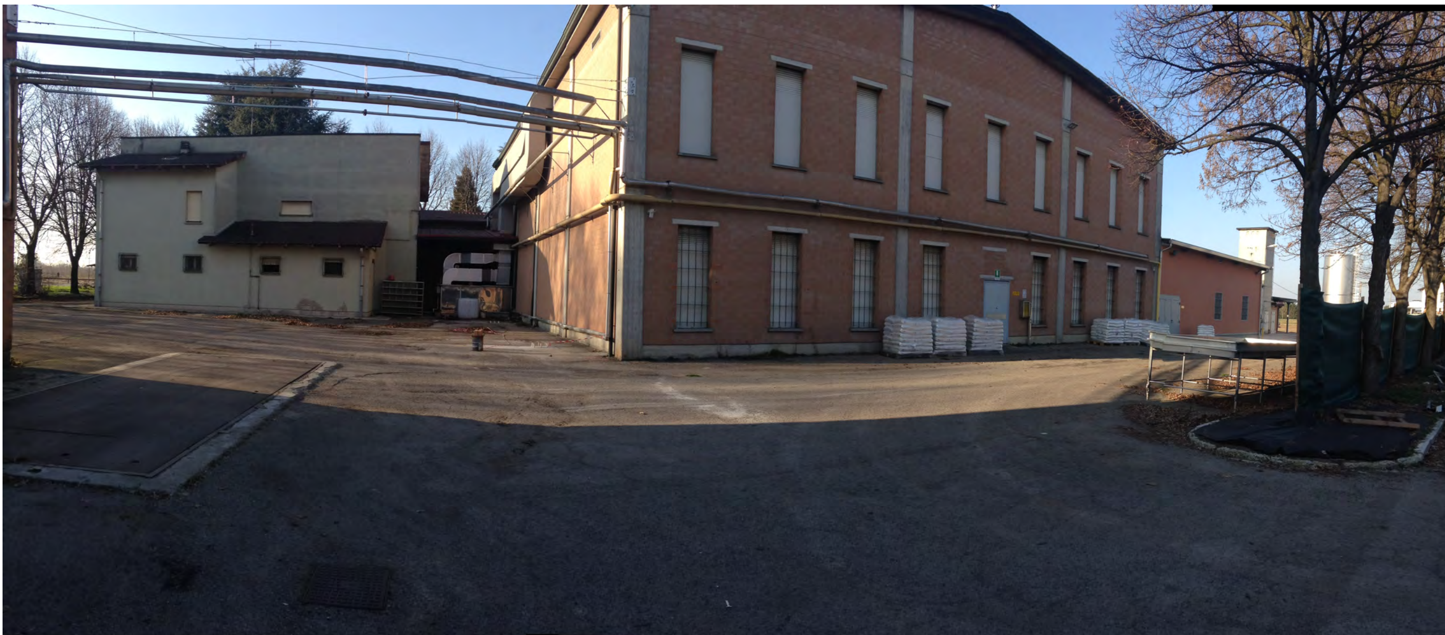
Fronte Est (parte Sud)
