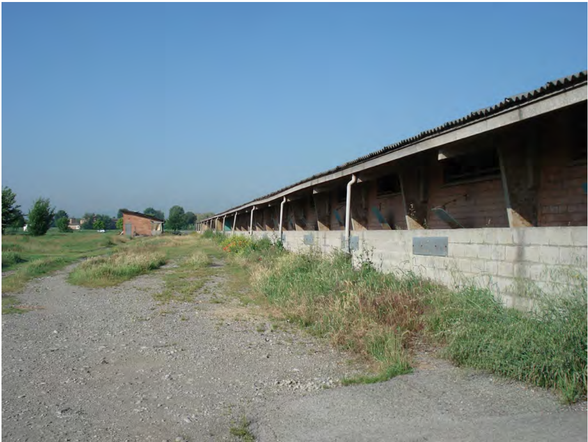
Foto 13. Le porcilaie, fronte Est
