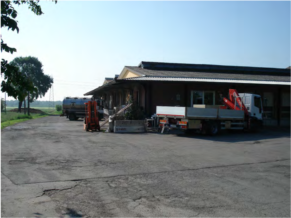
Foto 16. Il complesso Lato Nord
