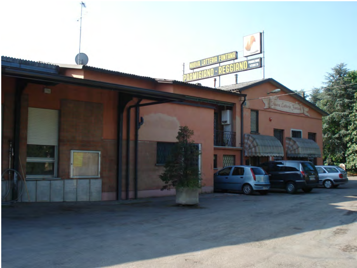
Foto3. Il fronte Ovest
