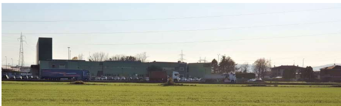
Foto 6 - Vista stabilimento UDOR a Sud
