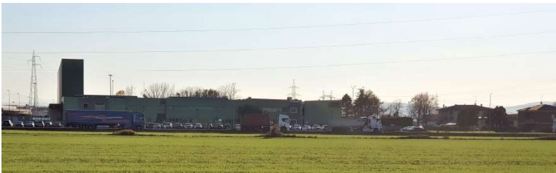
Foto 8 - Vista stabilimento UDOR a Sud
