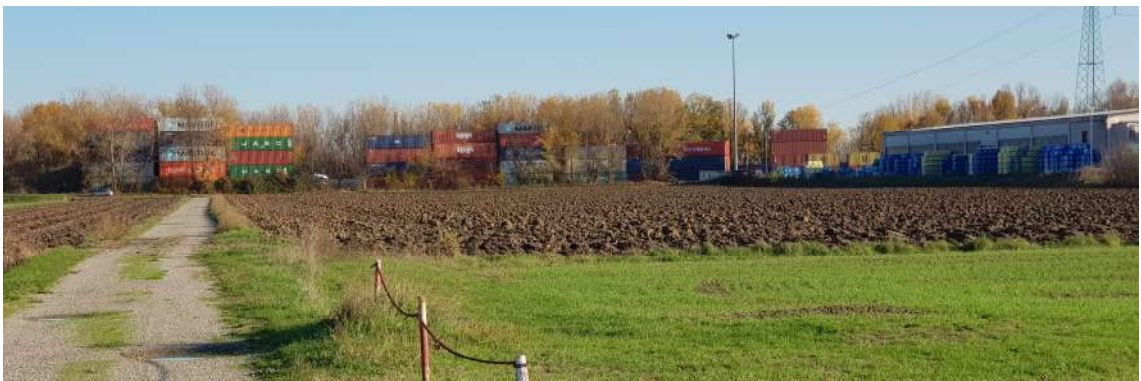
Foto 9 - Vista deposito containers ad Est (Terminal Rubiera)
