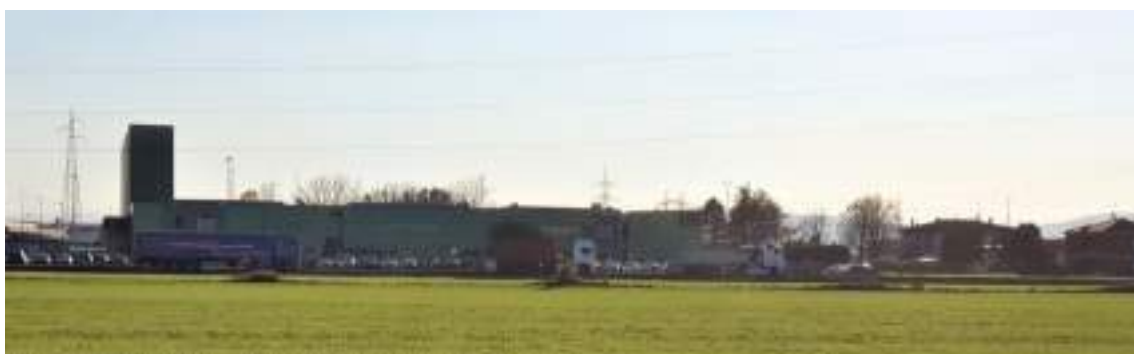
Foto 6 - Vista stabilimento UDOR a Sud
