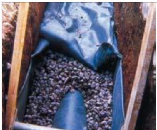
Figura 13: Una trincea d'infiltrazione (Fonte: EPA).
