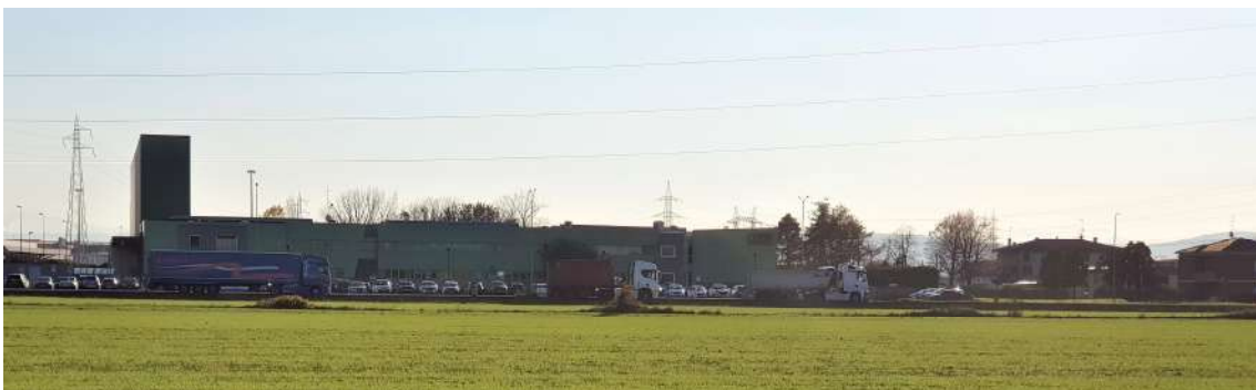
Foto 5 - Vista stabilimento UDOR a Sud
